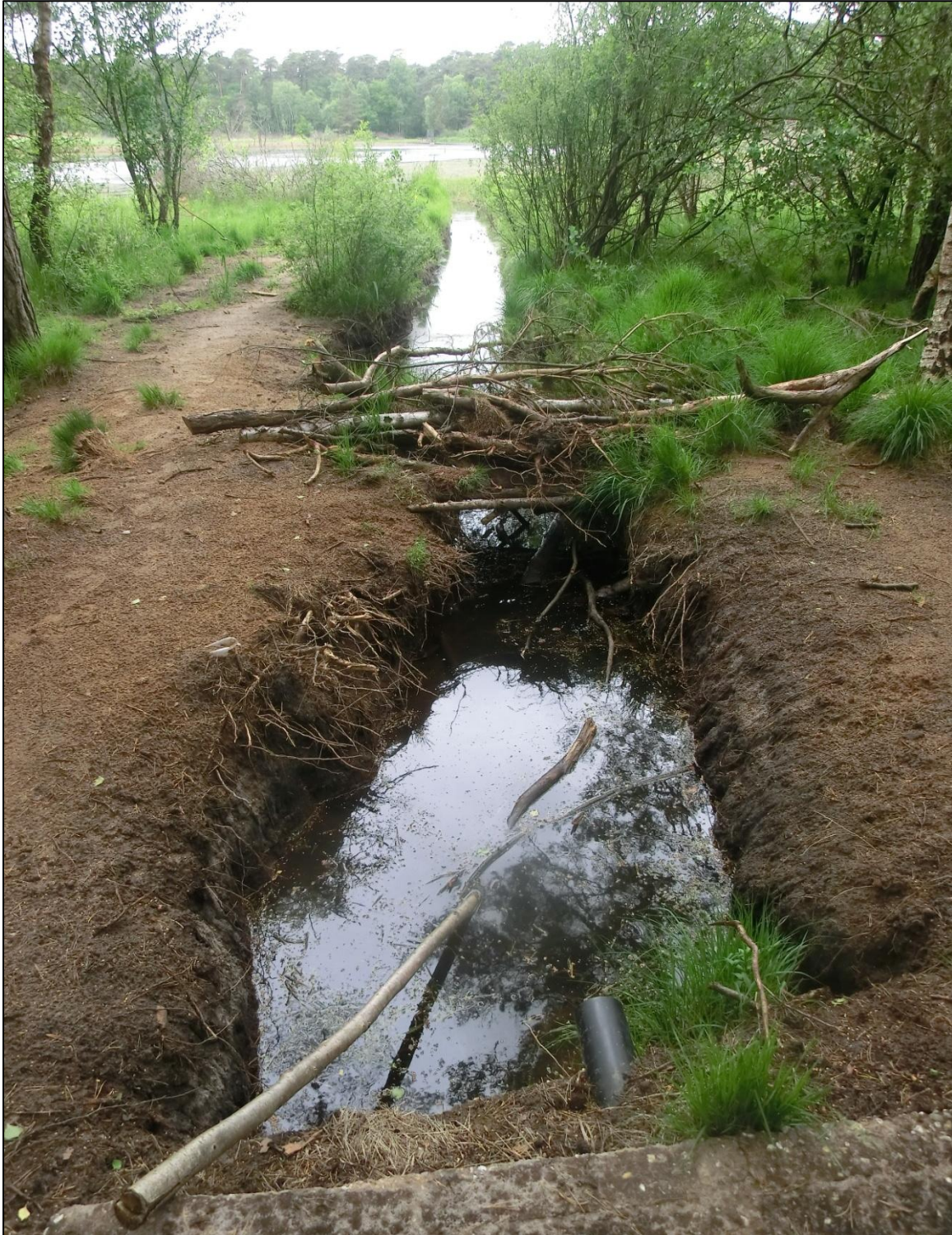
Figuur 3. De afvoersloot of ontwateringgreppel gezien vanuit het bos vanuit de zuidoostelijke hoek. In deze afvoer wordt een overstort geplaatst en wordt de onderste buis (niet zichtbaar op foto) afgesloten
